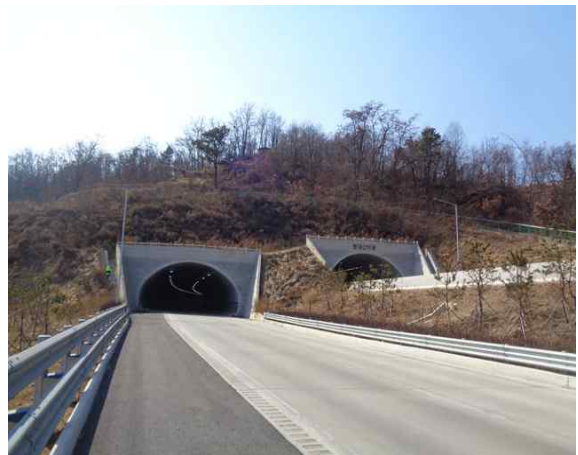
1공구 봉대산터널(문산) 종점부
