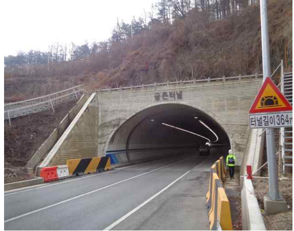
4공구 금촌터널(서울) 종점부
