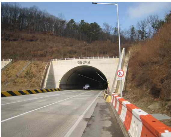
3공구 견달산터널(문산) 시점부
