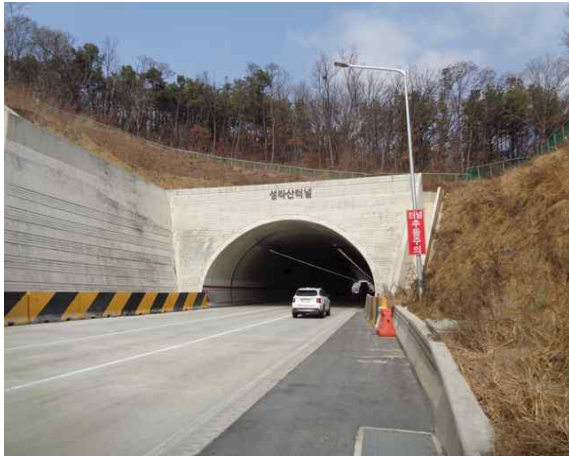
1공구 성라산터널(문산) 시점부
