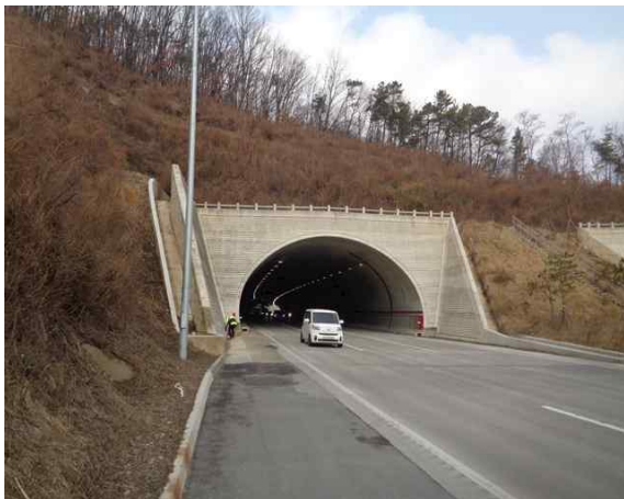
3공구 견달산터널(서울) 시점부
