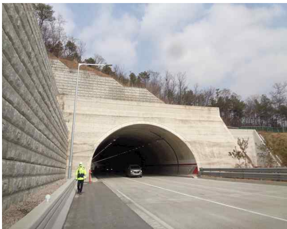
1공구 성라산터널(서울) 시점부
