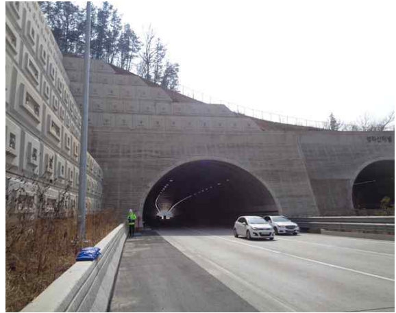
1공구 성라산터널(문산) 종점부
