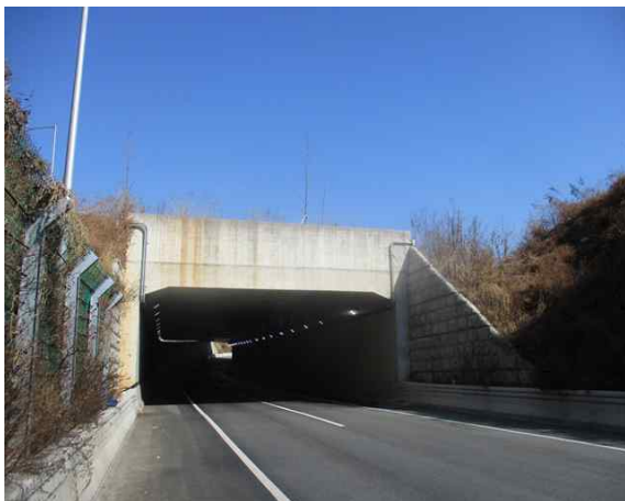
1공구 봉대산 지하차도 시점부
