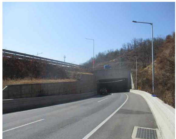
1공구 봉대산 지하차도 종점부
