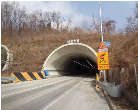
4공구 금촌터널(문산) 시점부
