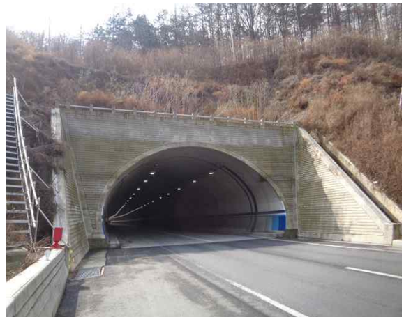
4공구 금촌터널(문산) 종점부
